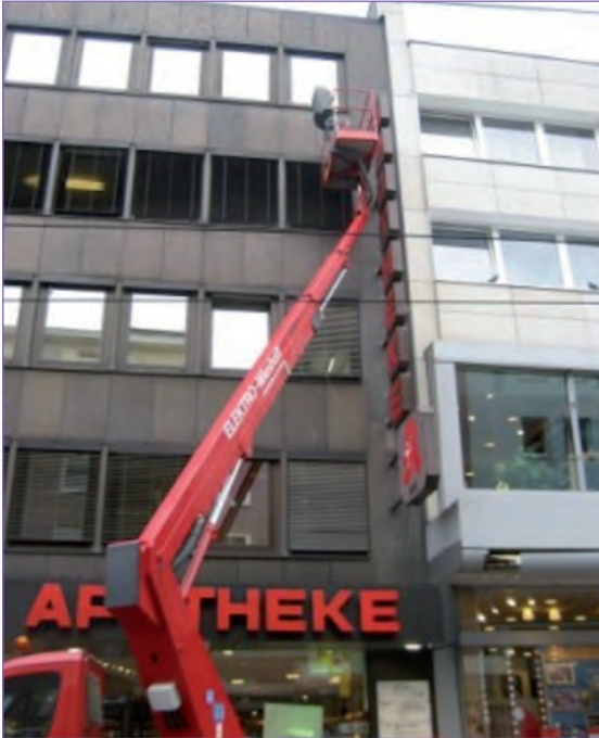
Montage von Ausstecktransparenten mittels Hubsteiger © Martina Gralki-Brosch
